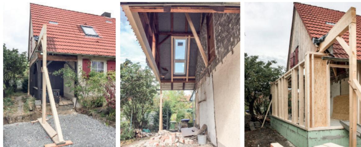
Linkes Foto: Die Laube und der Hühnerstall dahinter stehen noch. Ein langer, beidseitig abgesperrter Träger wird zum Abstützen des Giebels eingebaut. Der Abriss (mittleres Foto) kann beginnen. Aus Beton entstanden Fundament und Bodenplatte, mit der die Holzrahmenkonstruktion verschraubt wird.
