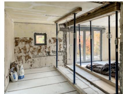
Bauphase: Ein in die Wand betonierter, nach außen gedämmter Betonquader und eine Stahlstütze dienen als Auflager für den hölzernen Unterzug.
