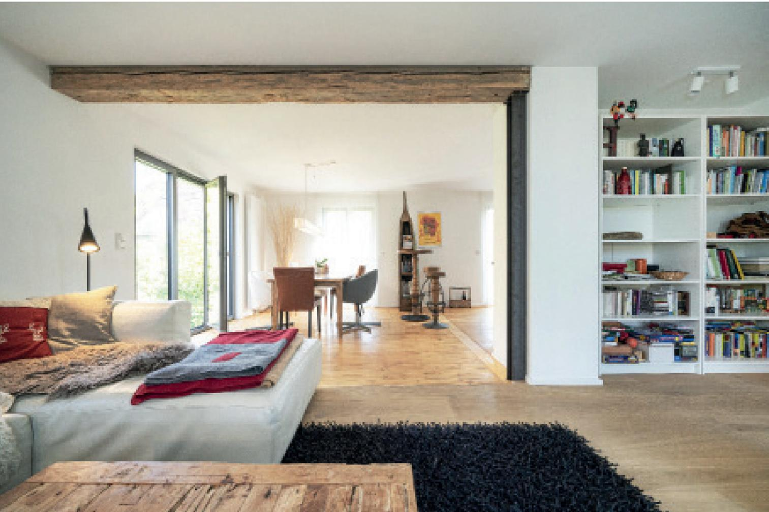
Ein 400 Jahre alter Fichtenbalken, recycelt aus einer ebenfalls von Heike Brumme sanierten Schlosskapelle, fängt die Deckenlasten im Bereich der entnommenen Zwischenwand ab.
